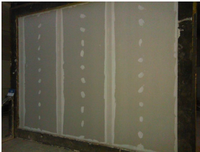
Fotografía n.º 2. Finalización de trasdosado
